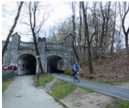
Viel besser: Der Tunnel unter der Max-Josef-Brücke
